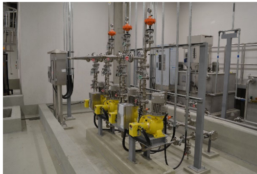
A-polimer oldógép a II. szennyvíz kezelő vegyszer termében
